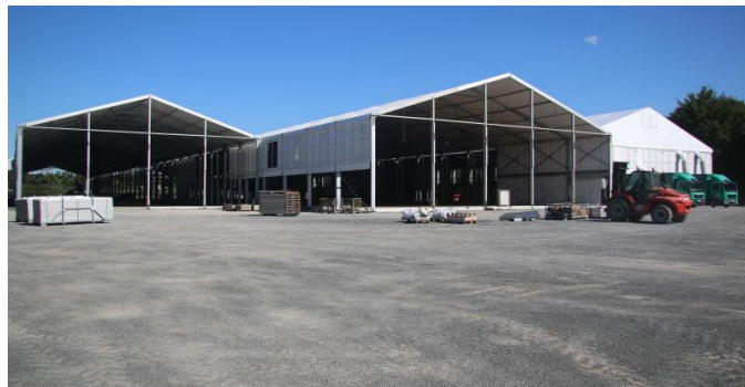
Seit Mitte August laufen die Aufbauarbeiten auf dem Festplatz.
