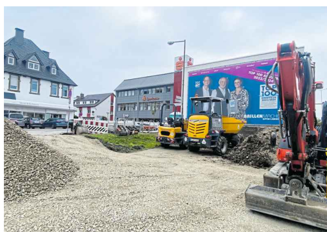
Auf der Investorenwiese werden Material und Maschinen für die Nahwärmbaustelle gelagert.
